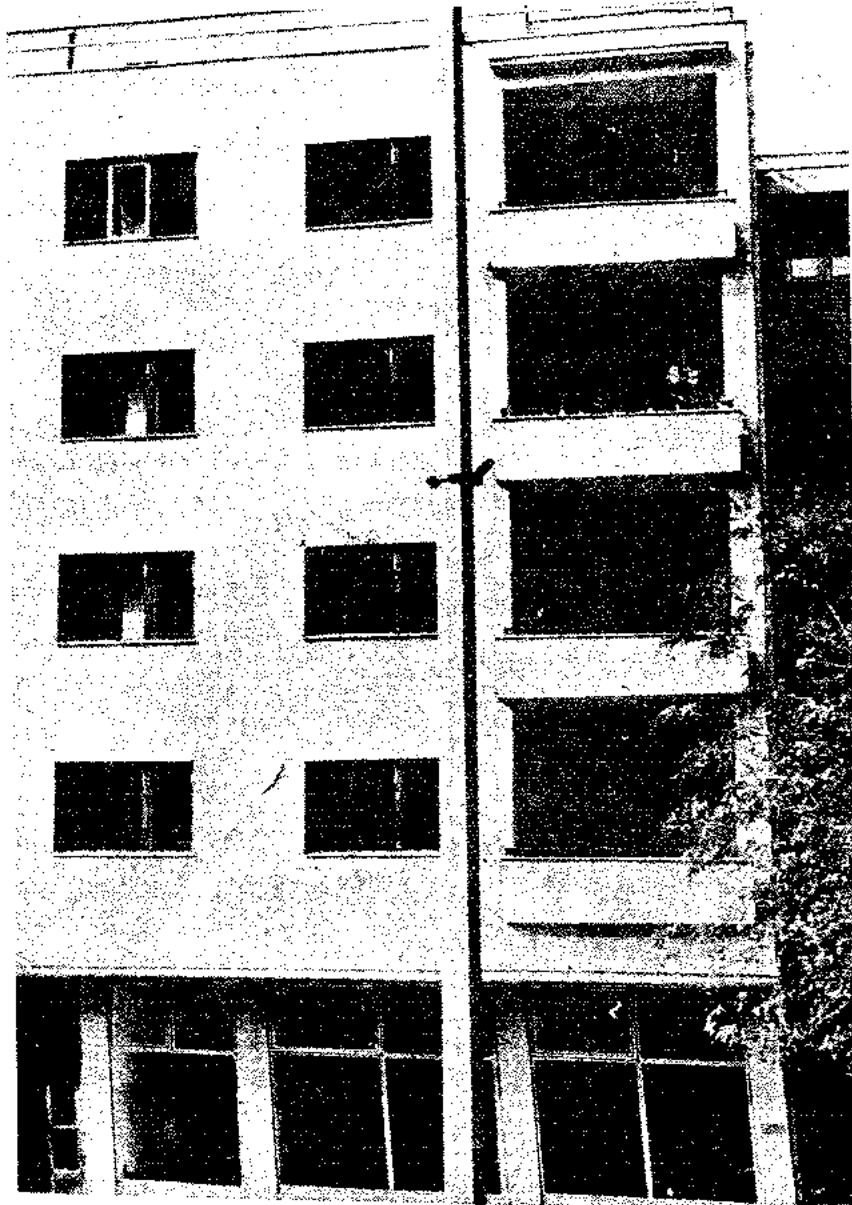
〈그림 17, 18, 19〉耐地震設計의 衝擊吸收軟層概念은 사진과 같은 被害를 防止한다.
