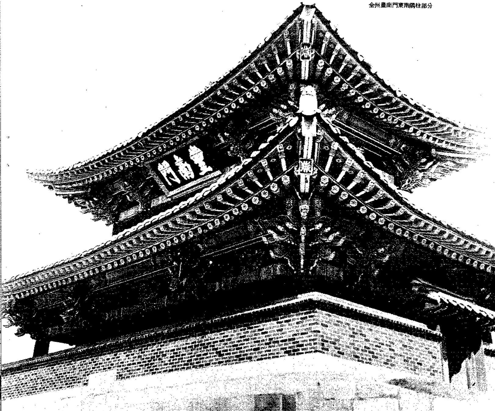
全州豐南門東南隅柱部分
