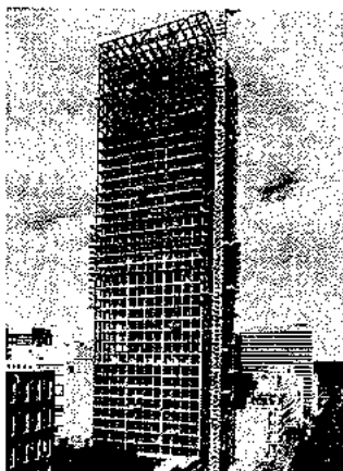
↑ 特殊 自動 타워 크레인을 使用 工事中인 BHP 빌딩
