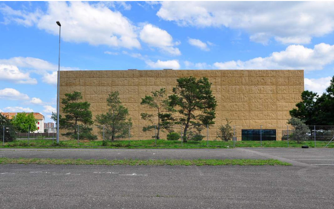
그림 9) 샤우라거의 측면, 공사 중 나온 자갈과 흙을 이용한 특수 콘크리트로 마감되어 있다.
