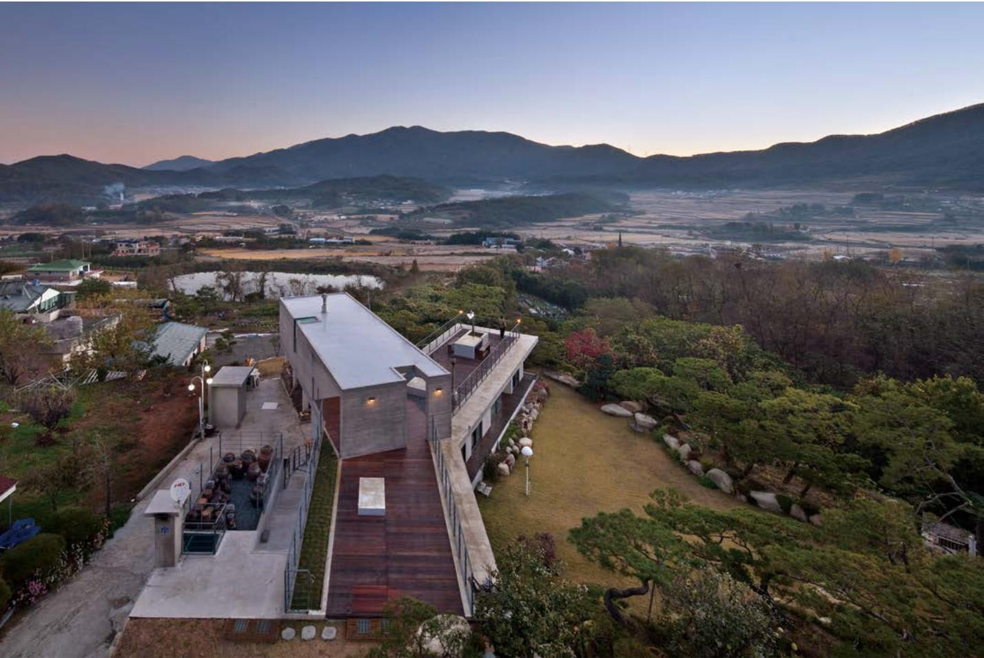
대지의 조건과 그 곳에 살고자 하는 사람의 생활 방식을 건축적인 방식으로 풀어낸 작품이다. 일과 거주, 두 기능을 대지의 고저차를 이용해 수직적으로 분리하였고, 조망과 공간 배치를 위해 수평적으로 분절하고 축을 변화시켜 구축의 개념이 선명하게 드러나면서 자연과 대비를 이루고 있다. 조형성과 함께, 기존 주택의 일부분을 통합하고 중단열을 이용한 노출콘크리트 시공은 설계자의 집중력과 노력을 짐작하게 한다. 다만 외부 공간으로부터 주택으로 진입하는 과정과 주택 내외부의 공간적 감흥은 다소 단조롭다고 생각한다.
