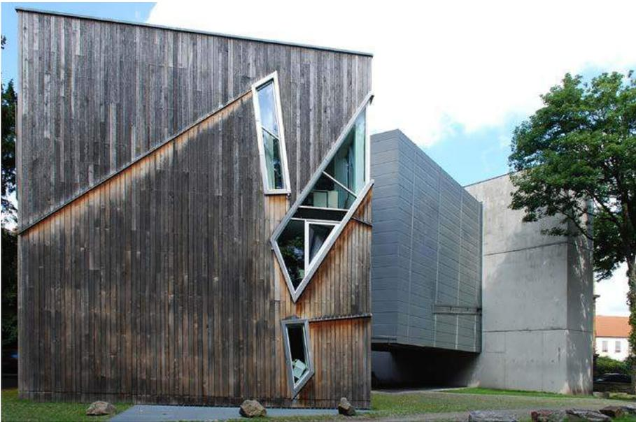
그림 8) 펠릭스 누스바움 미술관의 외관. 목재(주전시장)와 콘크리트(누스바움 길), 금속재를 사용하여 누스바움의 생애를 표현하고자 하였다.
