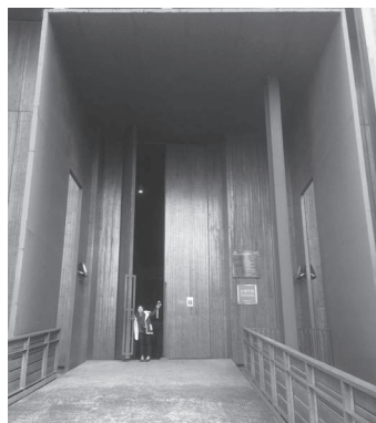
얇은 콘크리트 캐노피와 나무재질로 된 입구
