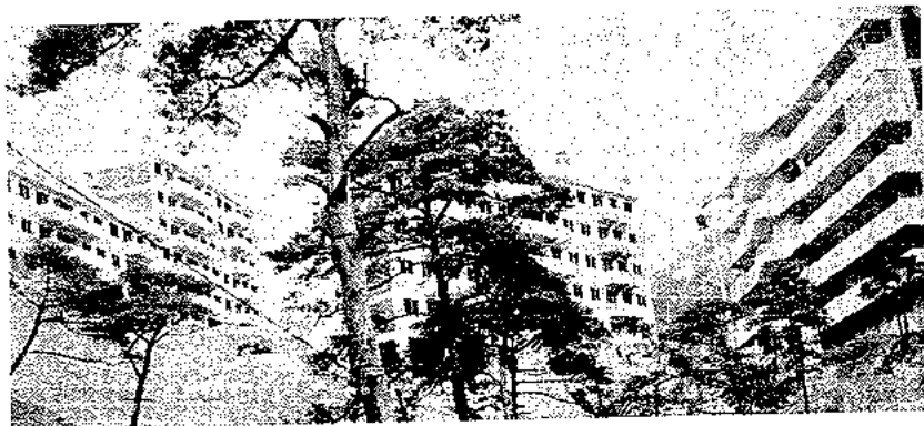
정운지구 아파트 전경
