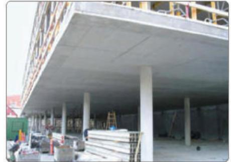
SLAF 공법 적용 후 전경 사진 (무량판 구조 : NO BEAM)
