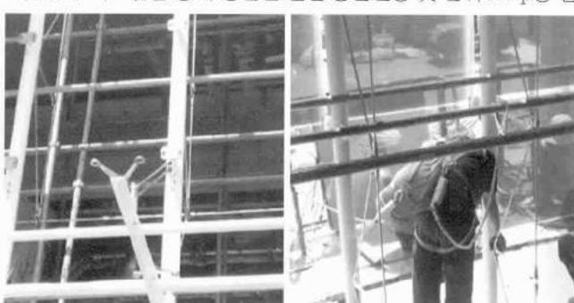
그림24. PV모듈 설치를 위한 SPG프레임 및 시공전경
