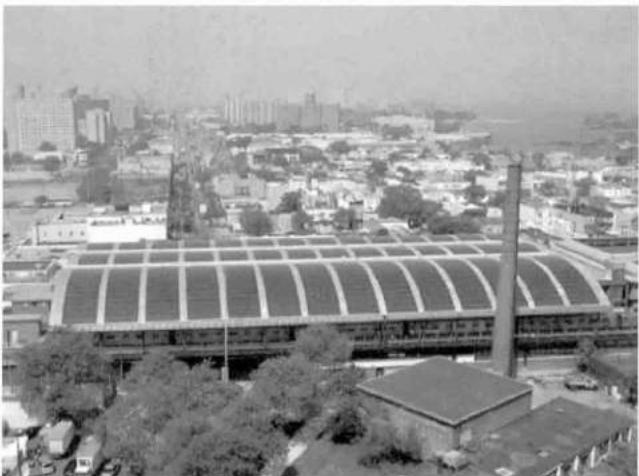
그림10. 외부에서 바라본 역사 지붕의 BIPV 시스템
