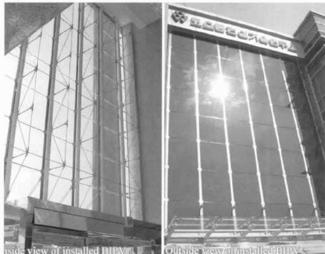
그림25. 투과형 박막 BIPV모듈의 설치 후 실내외 전경
