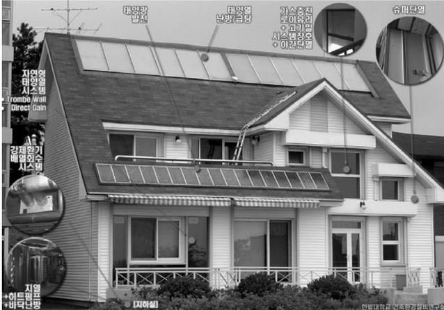
그림3. 완공된 KIER ZeSH I의 전경 및 주요 적용 기술
