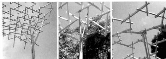
(그림 6) 좌 : 나뭇가지형태의 기둥 디자인의 예, 중 : 나뭇가지형태의 지지대를 케이블로 보강한 형태 우 : 상부 목 구조와 하부 지지대사이의 연결부위는 소켓(socket) 디테일
