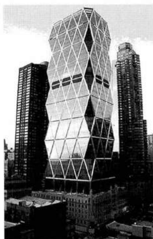
46층의 허스트 빌딩은 뉴욕의 대표적 녹색건물로 세워졌다. 그리드 프레임의 사용으로 약 20%의 철재의 절감을 가져 왔으며, 센서를 이용한 조명의 조절과 최신 설비 시스템을 갖추고 있다.
