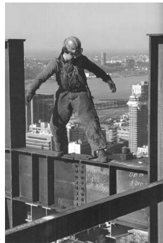
1. 맨해튼 고층 건물 공사 현장
