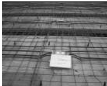
지상 6층 바닥철근배근 및 전기배관
