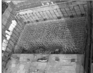
다목적실 시스템거푸집 설치
