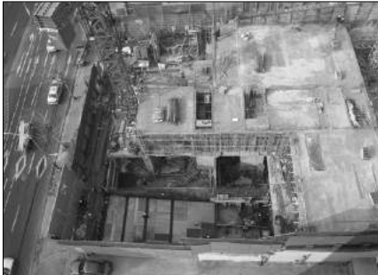
지상1층 바닥슬라브 콘크리트 타설완료
