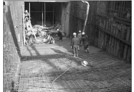
지하주차장 진입램프 콘크리트타설
