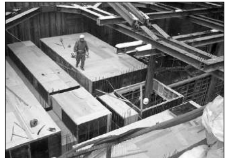
지하 2층부 철근배근 및 형틀조립작업
