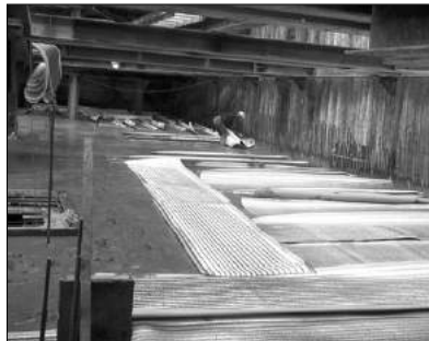
지하 2층 바닥콘크리트타설후 보양
