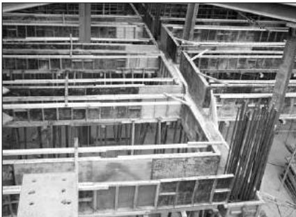
지하 1층부 철근배근 및 형틀조립작업
