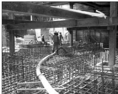
지하 3층 바닥 콘크리트타설
