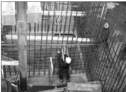
지하 3층 ELEV벽체 철근배근
