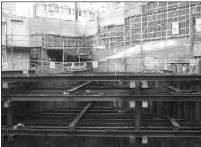
남측부 코너스트럿 설치
