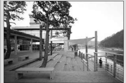
금강휴게소 / 인의식+장명희(건축사사무소 연미건축)
