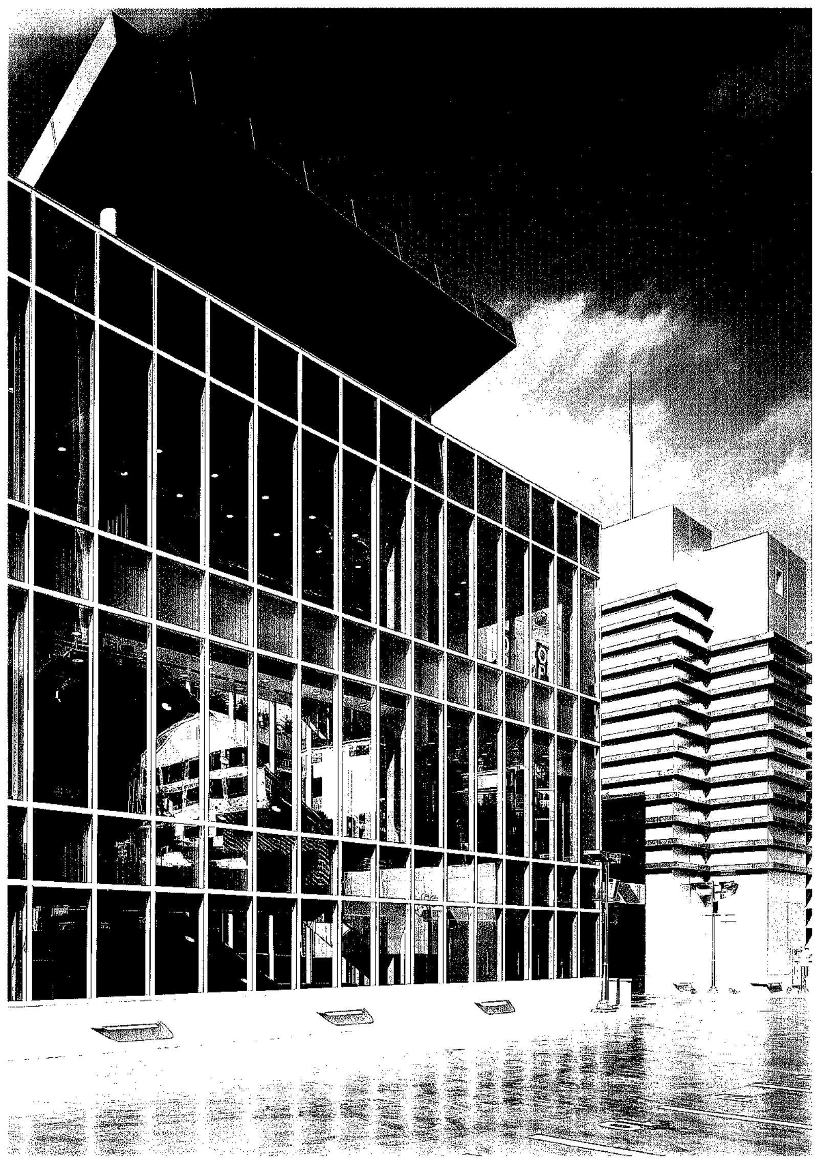
고, 결정된 최종안은 사업성의 극대화와 경비 절감의 방법으로서 기존 건물을 최대한 이용하면서 임대분양의 사업성이 있는 1층 부분만 확장 증축하고 다른 층은 계단실, 에스카레이터실 등 꼭 필요한 시설 부분만 덧붙이는 안으로 결정되어졌다. 1차안은 층별 면적 규모는 비슷하나 건폐율이 낮아 외부공간의 활용계획이 원활하여 보다 다양한 건축언어를 적용할 수 있었으나, 최종안은 1층 면적의 최대 확장 조건으로 인하여 외부공간 나누기가 극히 한정적일 수밖에 없었다.
