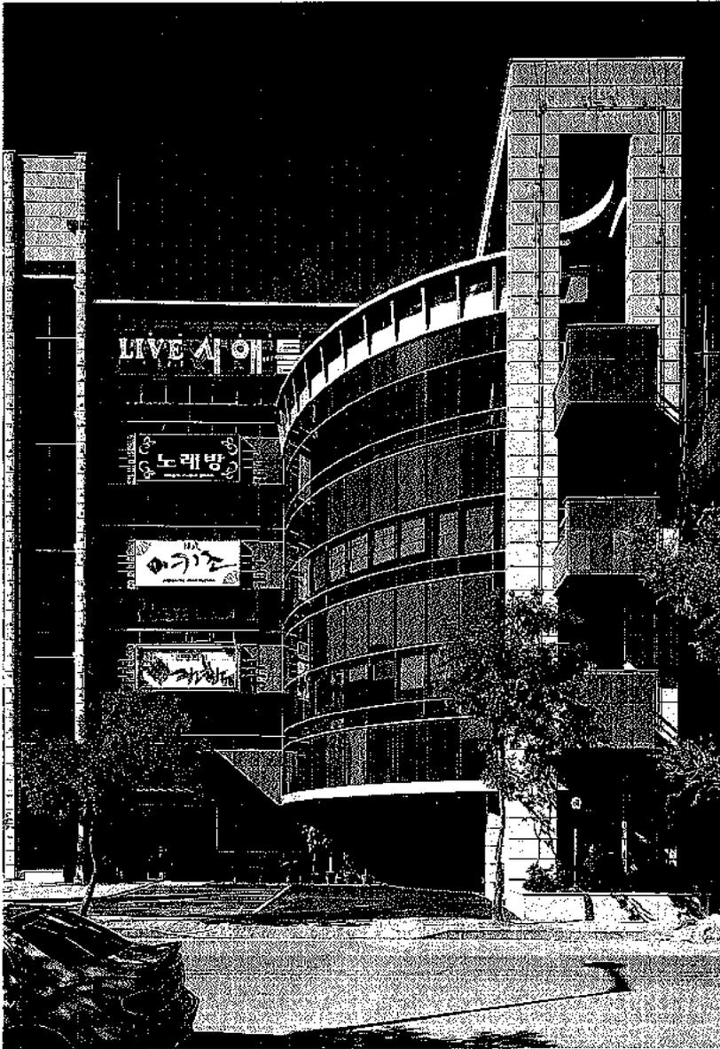
계획대지는 대지와 대지의 중간에 끼여 있는 평탄한 대지이며, 전면에 15m, 후면에 8m 보행자 전용도로에 접해 있고 긴 직사각형의 형태를 지니고 있다. 건물의 기본형태는 후면 도로경계선쪽의 건축지정선에 의하여 벽체를 일률적으로 맞추어야 했다. 주 평면은 사각형의 평면으로 하여 주진입에 따른 인지성을 고려하여 원을 내등분한 형태를 사각형 평면에 적합한 구성으로 최소의 면적으로 최대의 접근성을 주도록 하였다. 입면 구성으로는 5층의 규모로 주도로에서 인지가 잘 되도록 사각형 Mass에 원형의 곡선을 조합한 형태로 설계하였으며, 하늘 지붕과 발코니를 관입 시킴으로 발코니에서는 전망을, 하늘지붕으로는 Mass의 통일성을 구성하였다.
