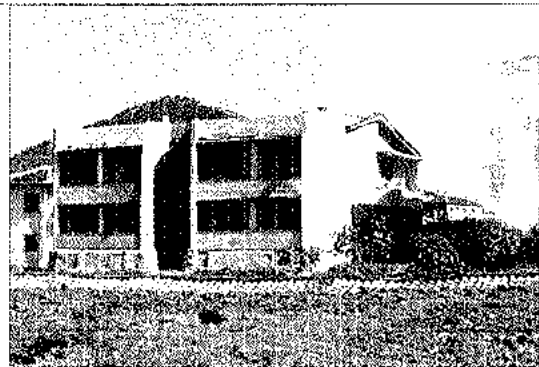
농촌문화주택의 건설 농촌지역에 건설되는 대표적인 문화주택이다. 그러나 벽의 단면을 보면 매우 거칠게 나타나고 있어 전문화된 기능공이 작업을 했다고는 보기 어렵다.
