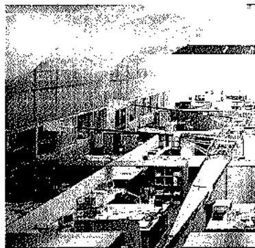
1930년대 지어진 공업적 용도의 창고 건물인 Deckelhalle은 Eco Membrane에 의해 Siemens 스튜디오를 위한 사무공간으로의 변화가 가능하게 되었다. 이 건물은 단열재가 없으며, 평면의 너비가 너무 깊어서 자연광이 건물의 중앙까지 들어오는 것이 어려웠다. 또한 외판은 변형없이 보존되어야 하므로 두 가지의 문제를 해결하기 위해 천장을 내고 꼭대기 부분과 처마마루에 환기를 위한 루버를 두었으며 건물의 외피와 내부의 새로운 막 사이의 공기층이 단열층을 형성하기 위해 투명한 막을 건물의 내부에 걸었다. 환경설비적인 측면과는 별도로 이 것의 설계자인 Herzog는 투명성에 관한 역사적인 원리를 재해석하였다. 이 스튜디오에서 일하는 동안 Siemens의 디자이너들은 과거와 현대의 건축기술에 대해 시각적으로 지속적인 자극을 받을 수 있었다.
