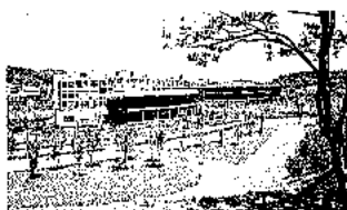
선경그룹종합연구소 전경 (정림건축 +미 CRSS, LAB, Consultant)
