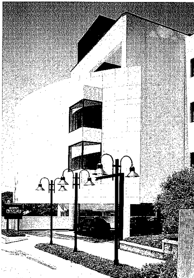
정면 주차장 및 옥외 조명시설
