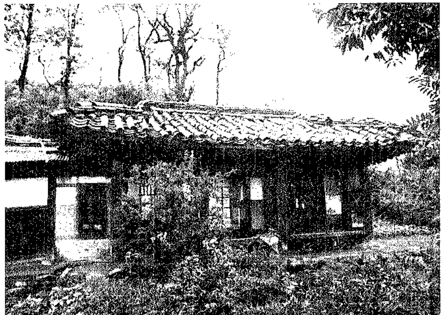
▲ 사랑채 정면 (파손된 기와를 보충치 못하여 임시번들로 비가 새는 곳을 손보았기 때문에 지붕이 엉겨주출한 양상을 보이고 있다.)
