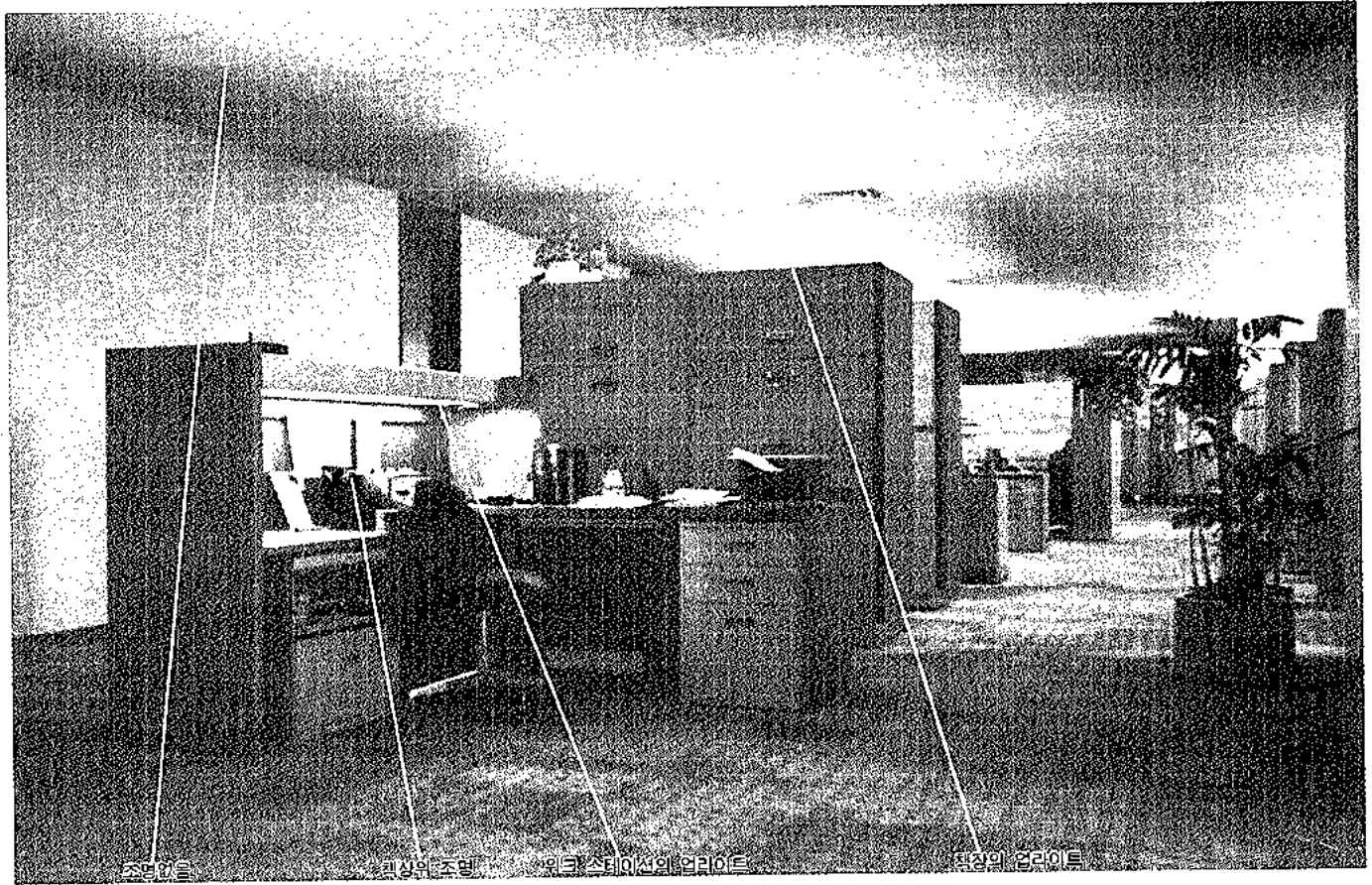
(사진 1) 어틀랜틱 리치필드회사(ARCO)의 데스크 엠비언트 조명방식
