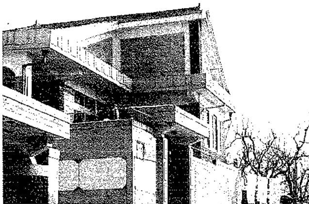
그림 4 근래 지어진 주택의 지붕-1
