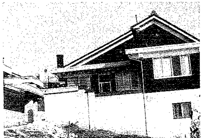
그림 5 근래 지어진 주택의 지붕-2
