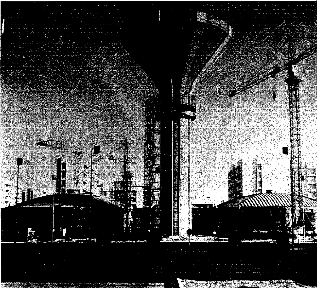
지상 약 40m의 3,000Ton 물탑은 알코바 Housing의 상징이기도 하다. 이 공法 역시 P.C工法을 적용하였다.
