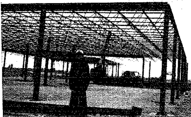
Space Deck으로 세워진 消防署 構造전경.
